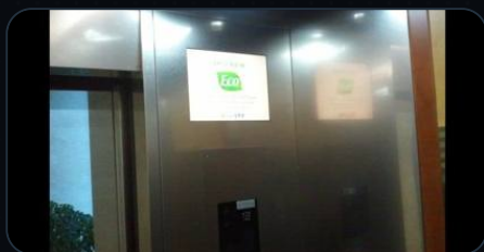
(주)오투기 엘리베이터(EV)매입 공사
