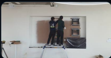
(주)아우름플래닛 멀티비전 설치
