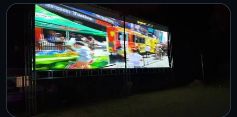
옥외용 고휘도 빔프로젝터 공사
