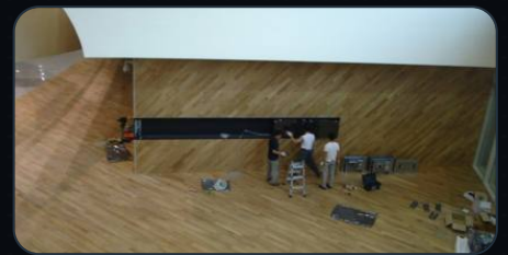
킨텍스 전시장 멀티비전 설치
