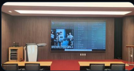
(주)시스원 멀티비전 설치
