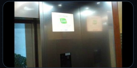
(주)오투기 엘리베이터(EV)매입 공사
