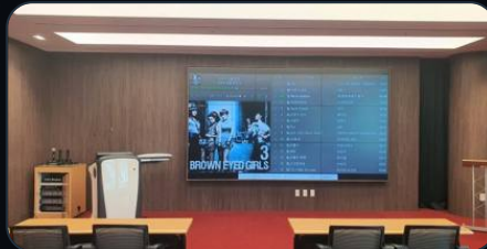
(주)시스원 멀티비전 설치
