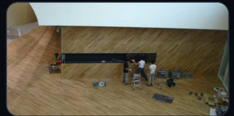
킨텍스 전시장 멀티비전 설치
