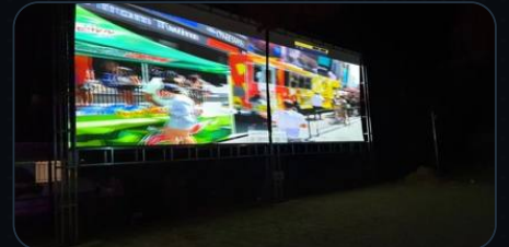
옥외용 고휘도 빔프로젝터 공사
